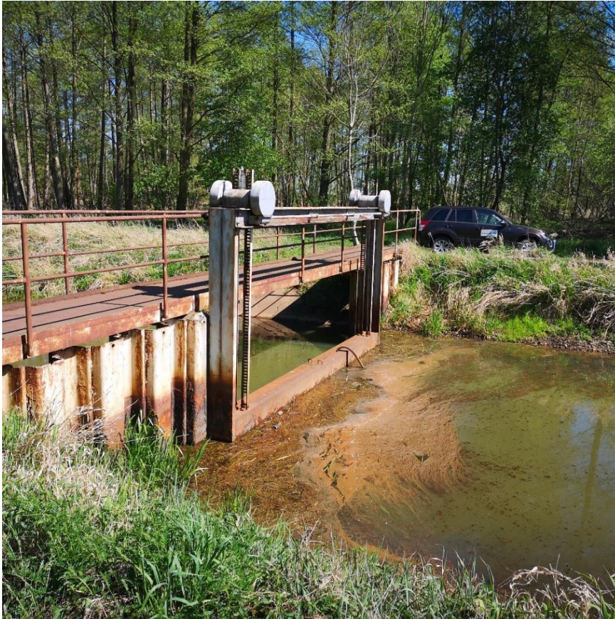
Wehr im Süpling, Station 3+560
